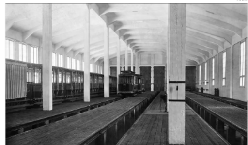
Kuvassa on arkkitehti Selim A. Lindqvistin suunnitteleman raitiovaunuhallien interiööriä. Hänellä ja rakennussuunnittelijalla Jalmar Castrénilla oli kokemusta teräsbetonirakenteista jo Suvilahden voimalaitoksesta sekä kaasulaitoksesta. Tila sopisi kirjoittajan mielestä tulevaisuudessa taidemuseoksi.
